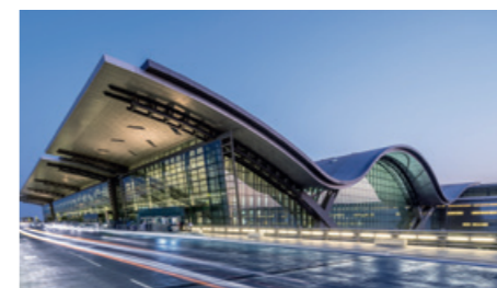
Aéroport International de Hamad Doha, Qatar
